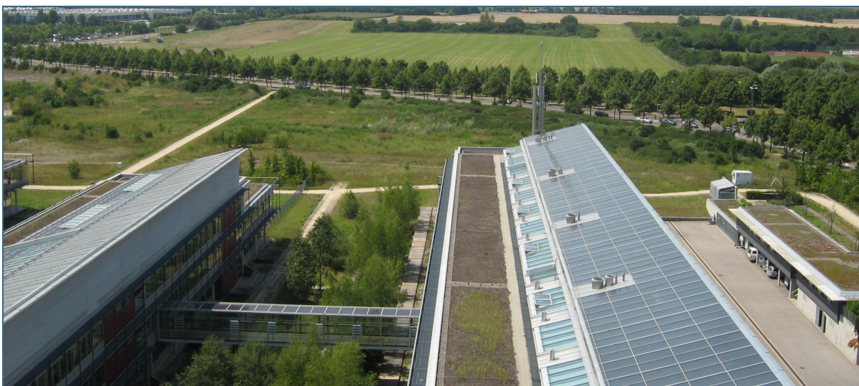
Abb. 5: Solarmodule auf den Dachflächen des LfU
