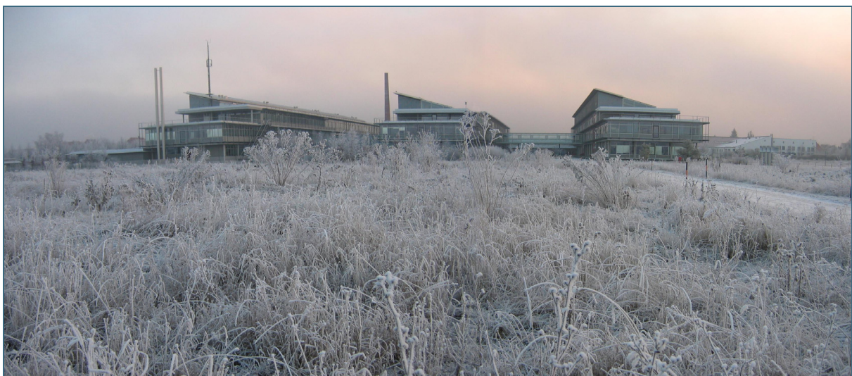
Abb. 1: Westseite des LfU vor der Bebauung mit Studentenwohnheimen
