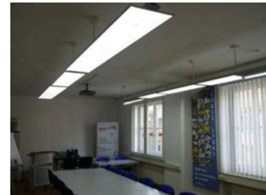
3-Achsbüro (**Musterraum**) Beleuchtungsstärke Arbeitsplatz ca. **1000 Lux** gemessen. Die **DIN EN 12464-1** fordert für Büroräume mit EDV-Anlagen Beleuchtungsstärken von **500 Lux**. Nach Verständigung des Auftraggebers wurde vom Planer eine neue Beleuchtungsberechnung angefordert, die ergab, dass anstatt der Bestückung mit 2 x 49 W je Leuchte eine Wattage von **2 x 35 Watt ausreichend** ist (zusätzliche **Einsparung 11.200 Watt**).
