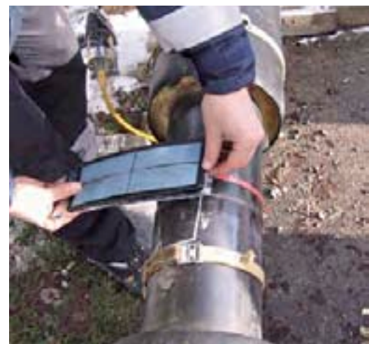
Anlegen eines Röntgenfilms auf eine zu prüfende Schweißnaht eines Rohres
