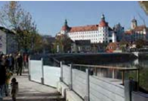
Hochwasserschutz Neuburg a.d. Donau – Probeaufbau der mobilen Elemente
