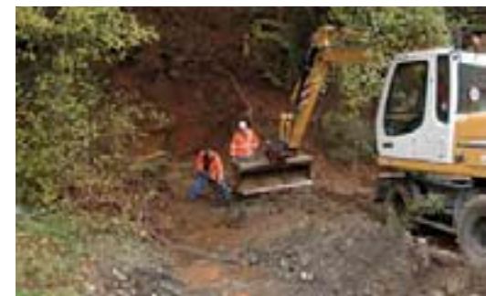
Quellschutz ist gelegentlich mit massiven Maßnahmen verknüpft. Hier, an einer Quelle bei Voggenthal (Neumarkt/Oberpfalz), wird der verbaute Quellaustritt wieder freigelegt und die Verrohrung entfernt.
