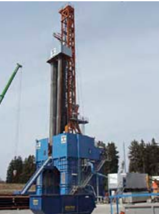
Bohranlage zur Erschließung von Thermalwasser
