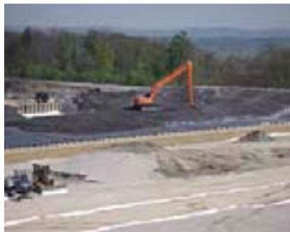
*Bild links: Asche aus der Müllverbrennung kann als Trag- und Ausgleichsschicht eingesetzt werden.*
