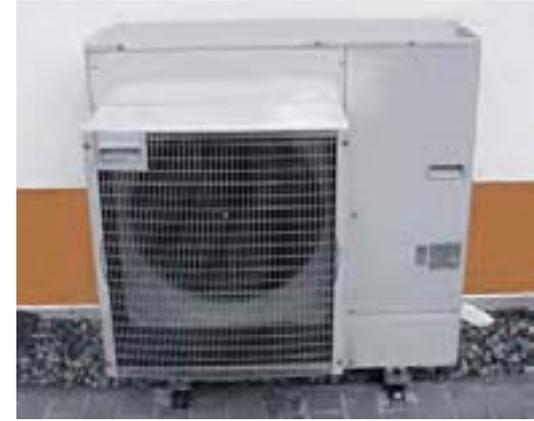
Luft-Wärmepumpen saugen Umgebungsluft an und nutzen diese als Wärmequelle. Beschwerden aus der Nachbarschaft lassen sich vermeiden, wenn dabei auch der Lärmschutz beachtet wird.
