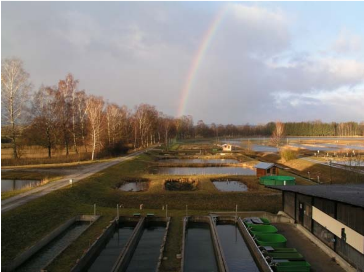
Teichanlage der Dienststelle Wielenbach bei Weilheim
