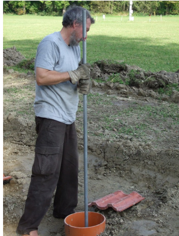
Abb. 13: Lagenweises Verdichten des Sandes
