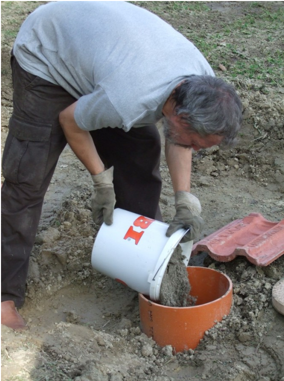
Abb. 12: Lagenweises Einfüllen des Sandes
