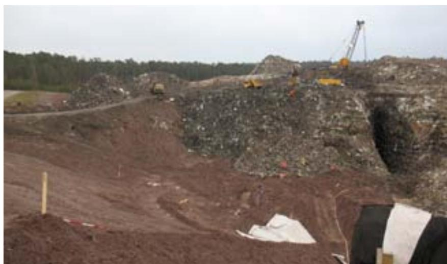
*Deponie Gosberg: Neue DK-II-Baugrube; im Vordergrund Schrägschachtbauwerk zur Sickerwassererfassung; im Hintergrund die Altdeponie mit Baugrube der Sanierungsmaßnahme des Sickerwassersystems.*
