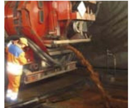
*Absaugen von Rückspülschlamm aus einem Absetzbecken und Entleerung des Saugwagens bei einer Entsorgungsfirma*
