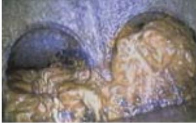
Starke Verockerungen an der Schachteinmündung der Sickerwasserleitungen am Surspeicher (Aufnahme aus einer Kanalbefahrung)
