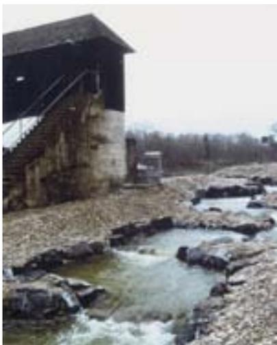
Wiederherstellen der Durchgängigkeit am Ickingener Wehr (Isar) durch eine Fischaufstiegsanlage (hier: Beckenpass)
