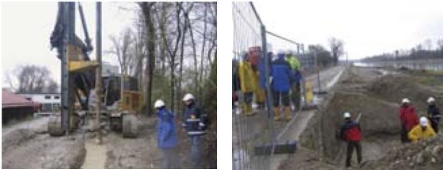
*Sanierung der Mangfalldeiche mit unbewehrten Erdbetonwänden (links) und Kontrolle der freigelegten Erdbetonwand (rechts)*
