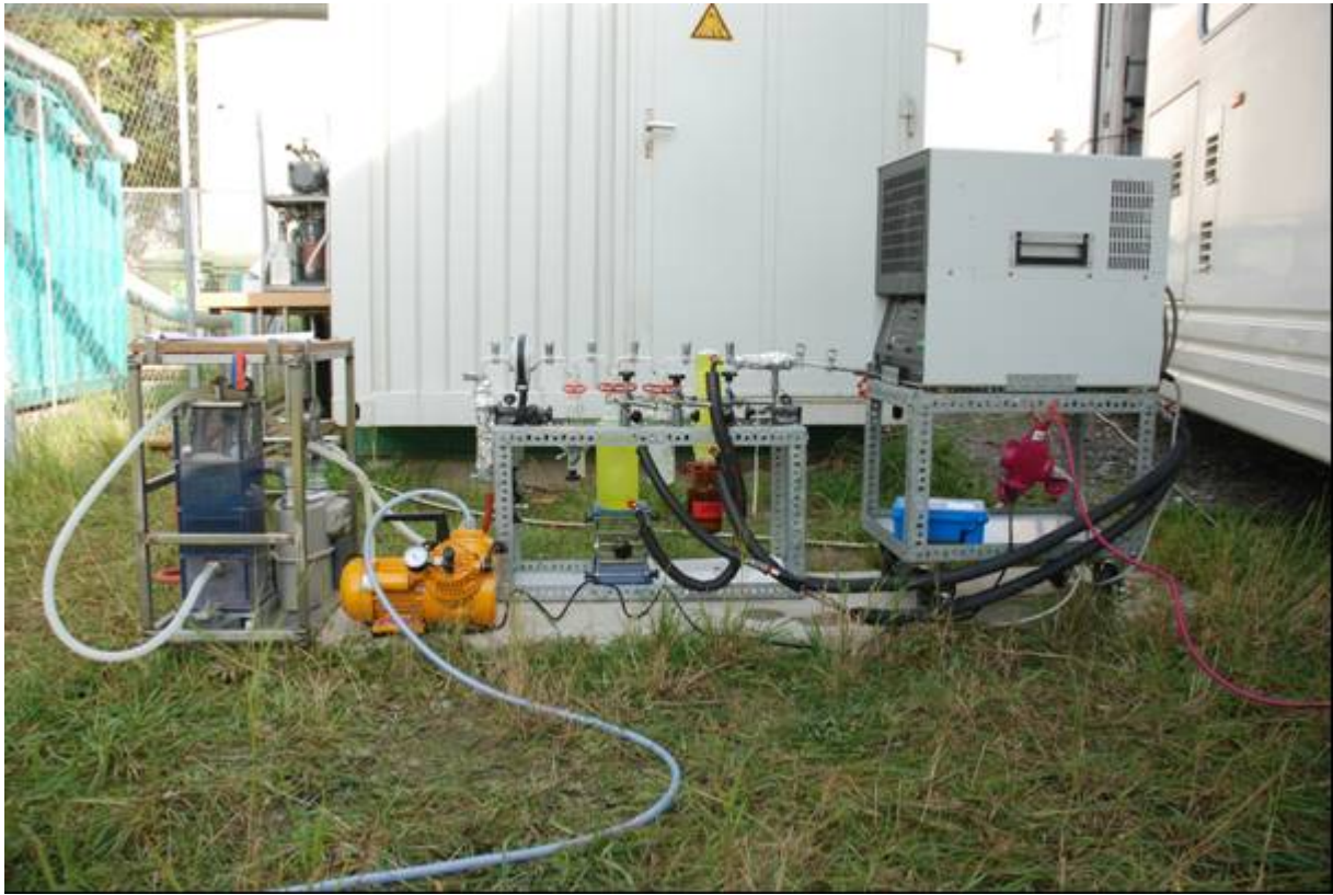
Abb. 6: PCDD/PCDF-Probenahme des Deponiegases an der Deponie C
