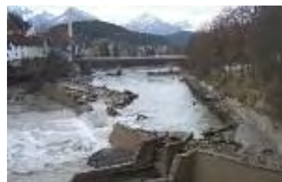
Vom Augusthochwasser 2005 teilweise zerstörtes Schwarzenbachwehr bei Füssen
