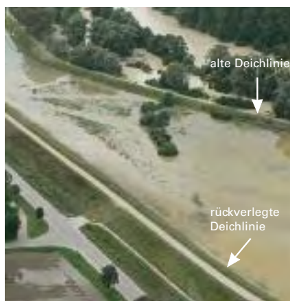
Bild links: Rückbaustrecke Mündung der Dorfen in die Isar (nach Hochwasser August 2005)
