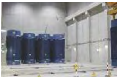
Einlagerung eines CASTOR-Behälters
