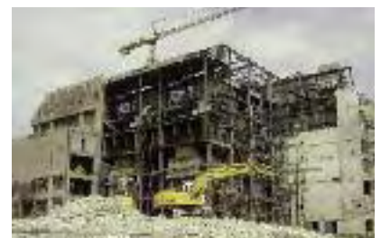
Abbruch des Kesselhauses
