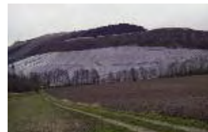
Sanierungsbeginn des Schlackenberges in Sulzbach-Rosenberg
