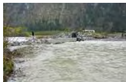
Bild oben: Blick vom linken Ufer nach unterstrom: geschlitzter Stützgurt mit Querbalken zum Durchlass umgebaut. Funktion: gedrosselter Geschiebetransport bei Hochwasser
