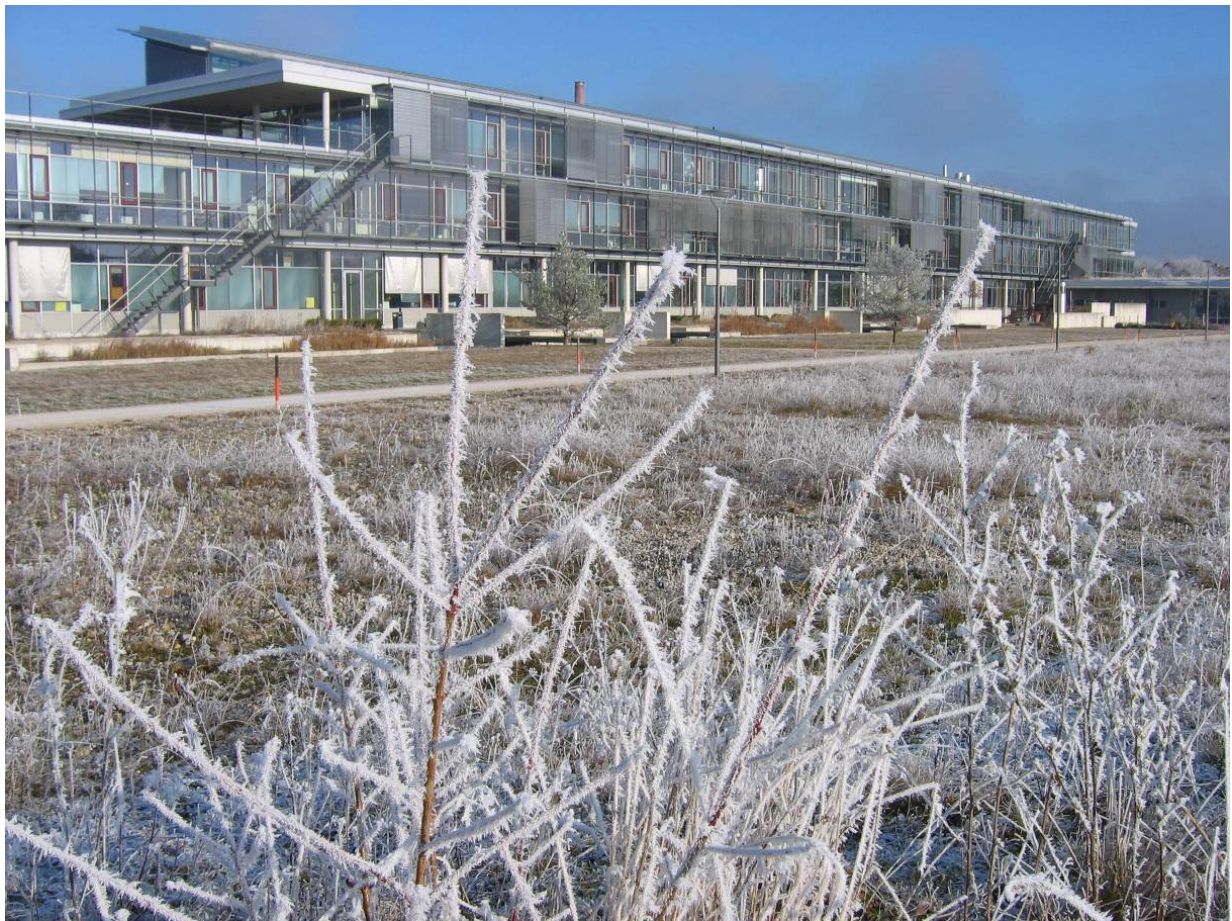
Südseite Verwaltungsgebäude 2 im Dezember 2004
