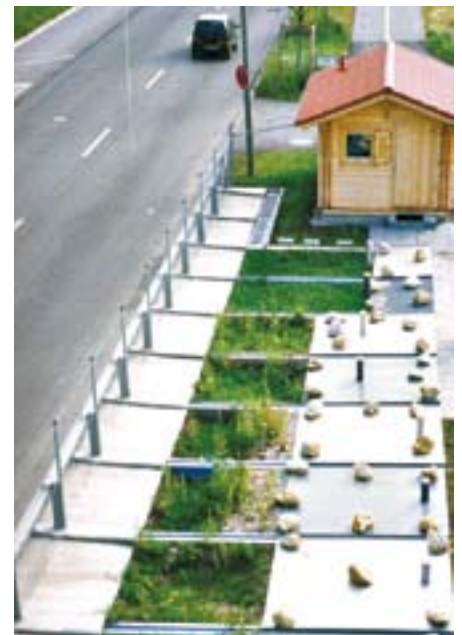
Versuchsanlage zur Versickerung von Straßenwasser
