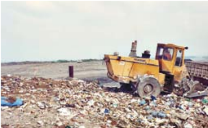
Deponie früher: Der Abfall wurde einfach nur abgelagert und verdichtet.
