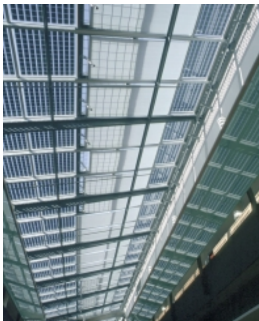
Abb. 16: Photovoltaikzellen
