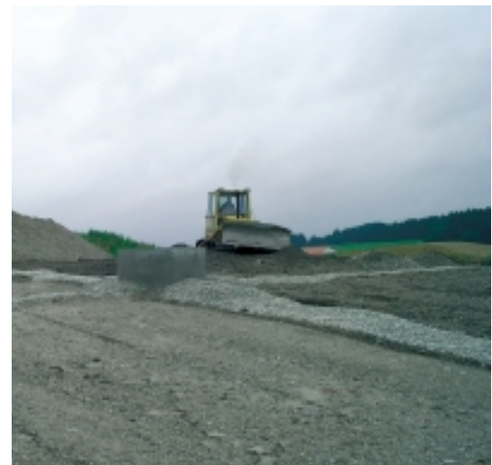
Abb. 9: Errichtung einer Gasdränschicht
