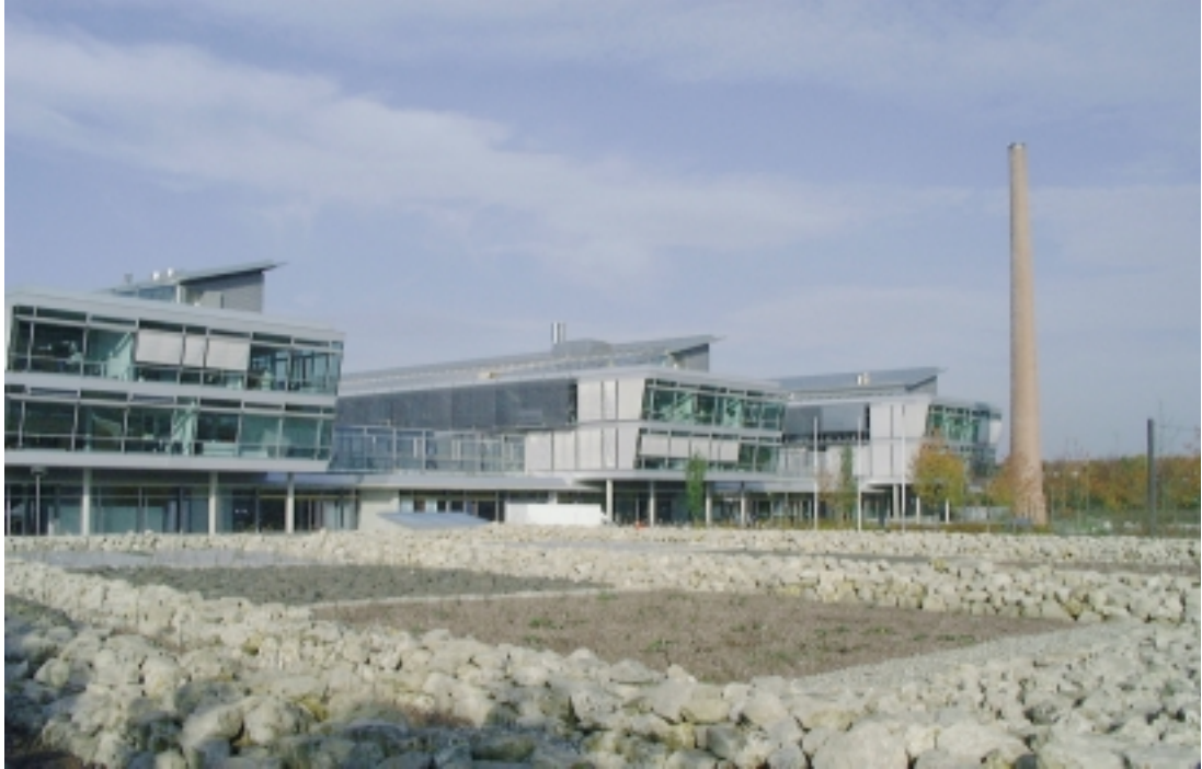
Abb. 4: Außenansicht des LfU
