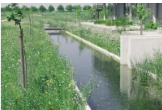
Abb. 20: Regenwasserrückhaltebecken
