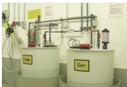
Abb. 21: Neutralisationsanlage
