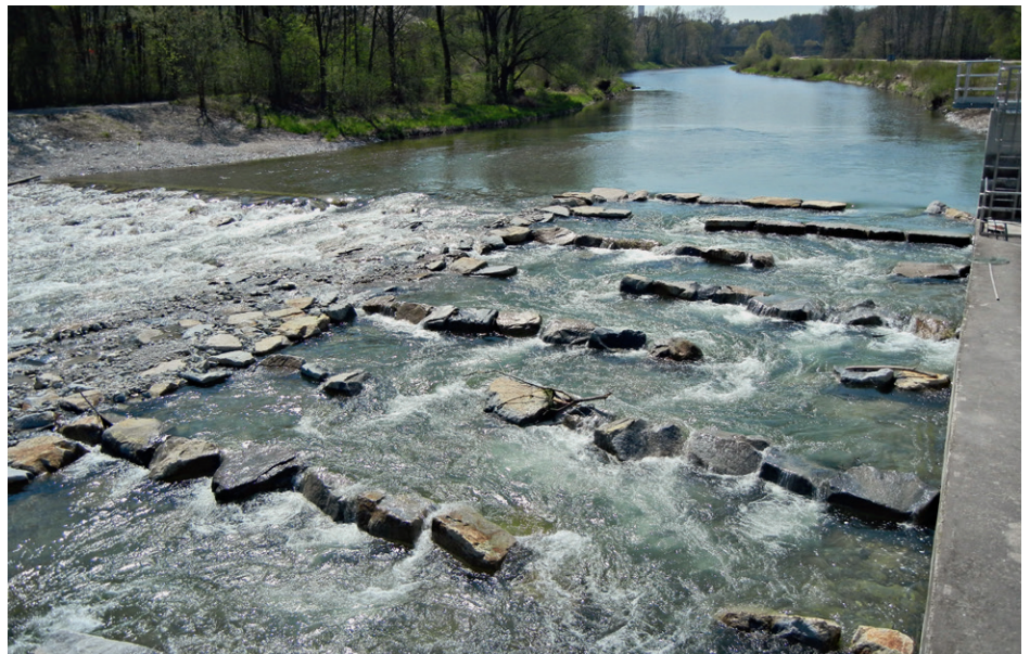
Sohlgleite nach dem Umbau
