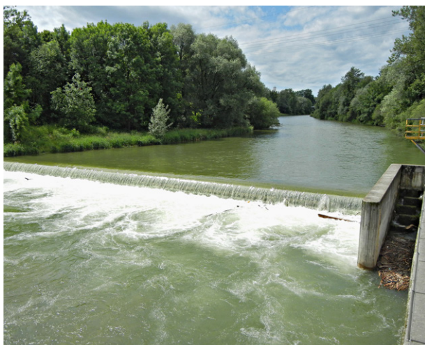
Querbauwerk vor dem Umbau
