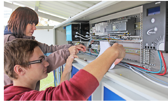
Installation der Elektrotechnik
