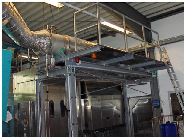
Der Wärmetauscher auf der Mangelanlage liefert unter anderem die komplette Energie für die Fußbodenheizung.
