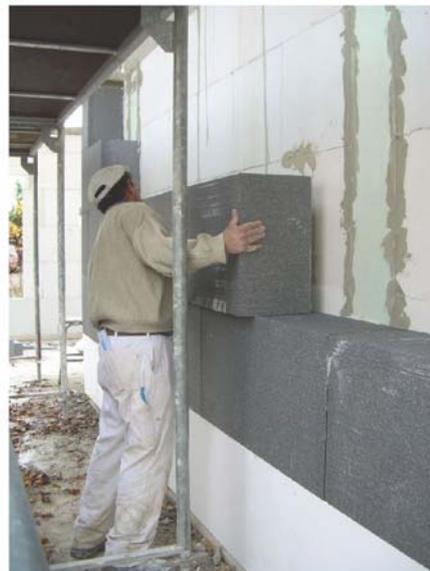
Wärmedämmverbundsystem zur Dämmung von Außenwänden (hier Passivhaus-Standard)
