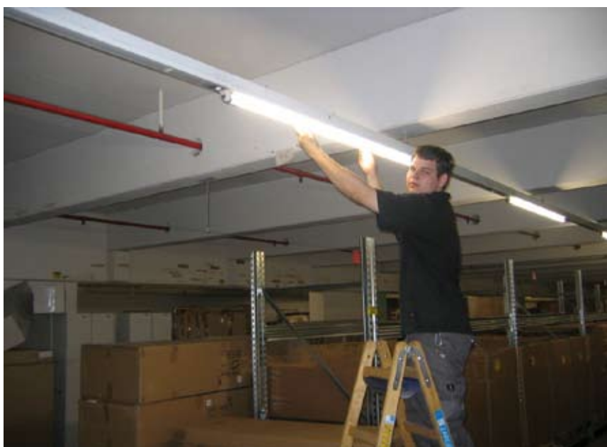
Baur-Techniker baut überflüssige Leuchten aus.
