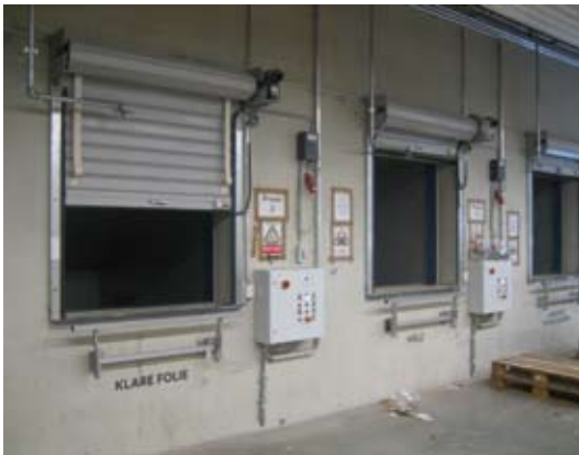
Wertstoffcontainer stehen im Hof und können von innen befüllt werden. Rolltore schützen vor Wärmeverlust.
