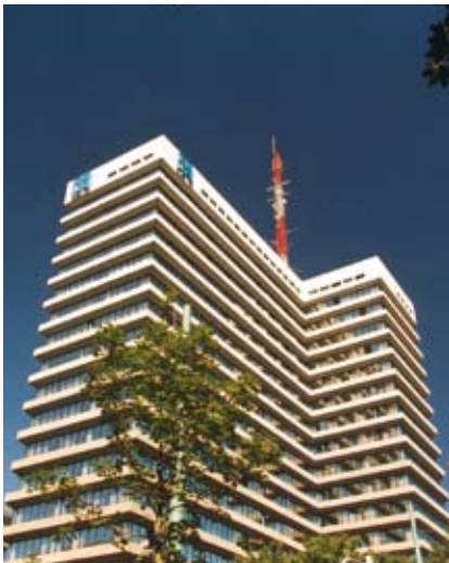
Dieses Gebäude des Bayerischen Rundfunks wurde mit light@FM optimiert.
