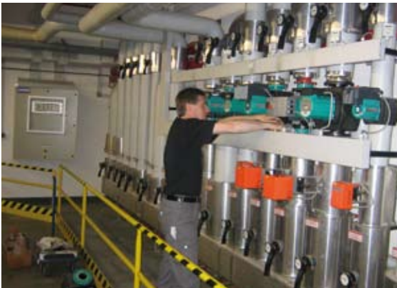
Baur-Techniker wechselt eine unregelmäßige gegen eine geregelte Heizungspumpe aus – 30 weitere folgen in Kürze.
