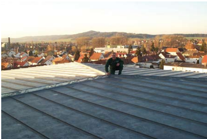
Die Regenwasser-Sammelfläche – das Dach der Brauerei
