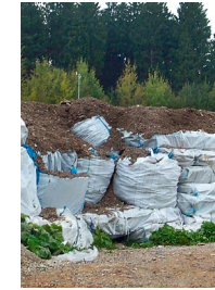
Eingebaute Big Bags auf einer Deponie
