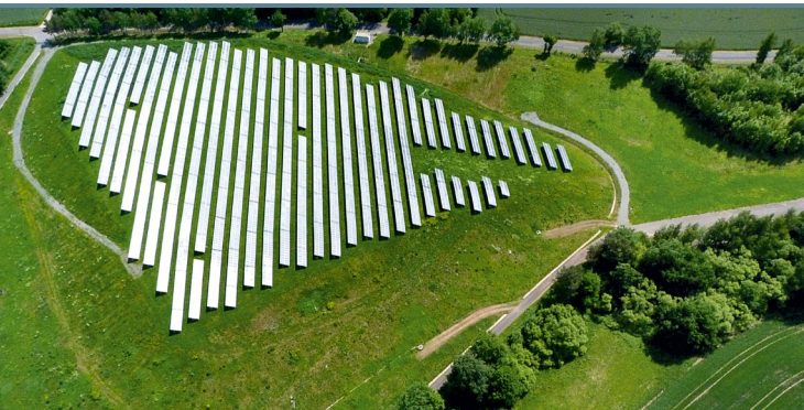
Abgeschlossene Deponie mit Photovoltaikanlage.
