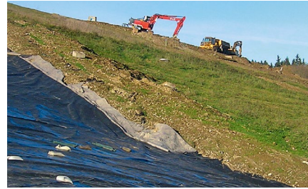
Deponieoberflächenabdichtung mit teilweiser Rekultivierungsschicht
