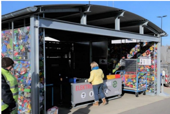
Neue überdachte Annahme für Elektro- und Elektronikaltgeräte mit Übergabetisch am Wertstoffhof Dasing, Landkreis Aichach-Friedberg
