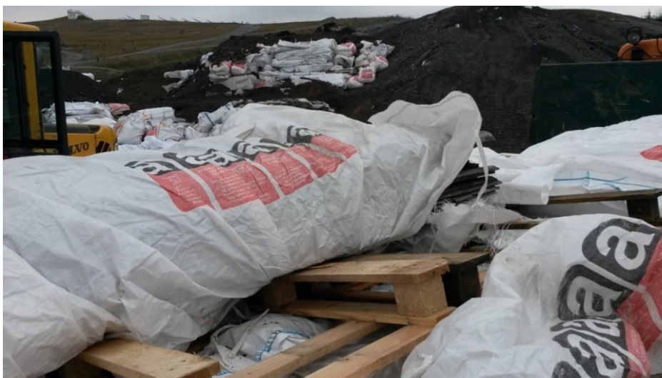
Abb. 3: Angelieferte Plattenbags auf Holzpaletten → Hohlräume
