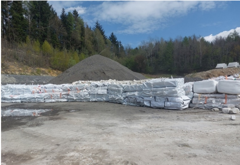
Abb. 4: Hohlraumarmes Einbau von Asbestzement in Plattenbags und gepressten KMF
