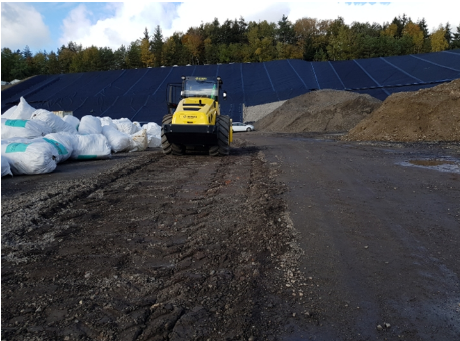
Abb. 6: Testfeld 2 nach 15 Übergängen (längere Setzungsdauer, höhere Vorverdichtung)
