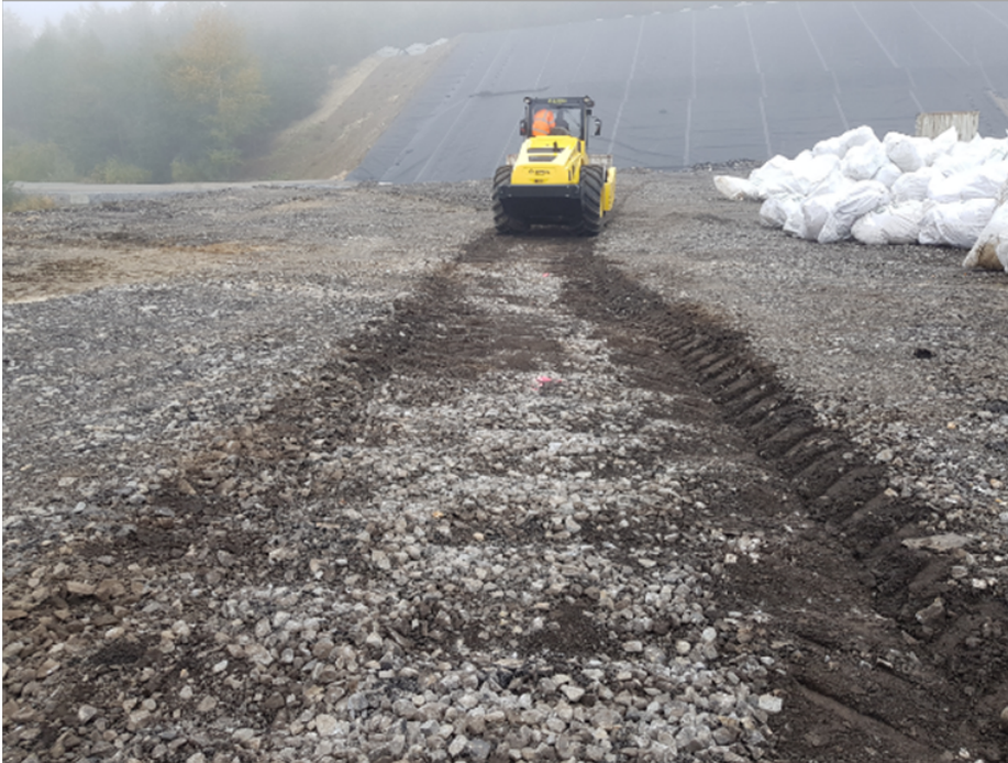
Abb. 5: Testfeld 1 nach acht Übergängen
