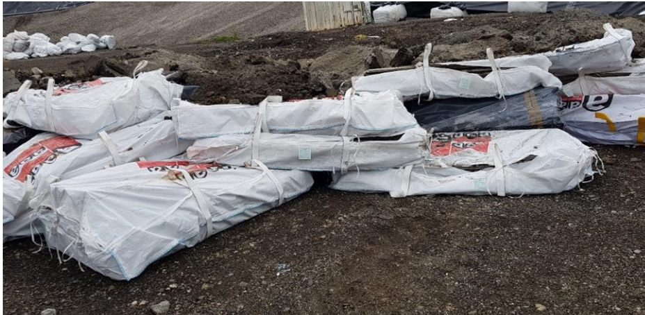
Abb. 2: Hohlräume beim Abfalleinbau
