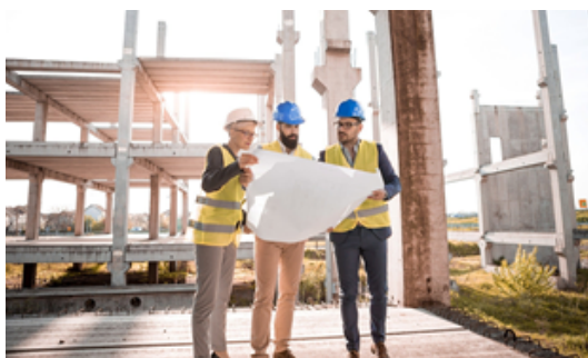
Abb. 6: Planerin, Bauherr und Bauamtsvertreter tauschen sich während der Bauphase aus.
