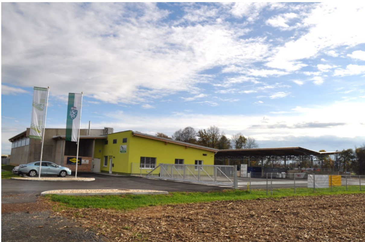
Außenansicht des „Ressourcenparks“ Ratschendorf: Gebäude mit Büro und Annahmehalle, im Hintergrund die Sägezahnrampe unter Flugdach im Freien. Das Gelände bietet ausreichend Parkplätze und Manipulationsflächen.
