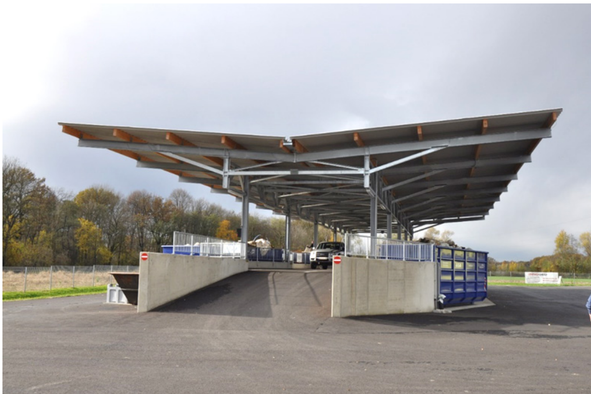
Außenansicht des „Ressourcenparks“ Ratschendorf: Sägezahnrampe zur Anlieferung sperriger Fraktionen (Sperrmüll, Alteisen, Altholz, Kartonagen etc.) unter Flugdach im Freien. Durch die Sägezahnrampe wurde eine Entflechtung von Privatanlieferverkehr und Werksverkehr zur Manipulation der Container erreicht.
