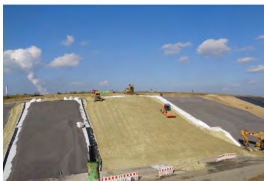
Baumaßnahme auf der Deponie Burgau
