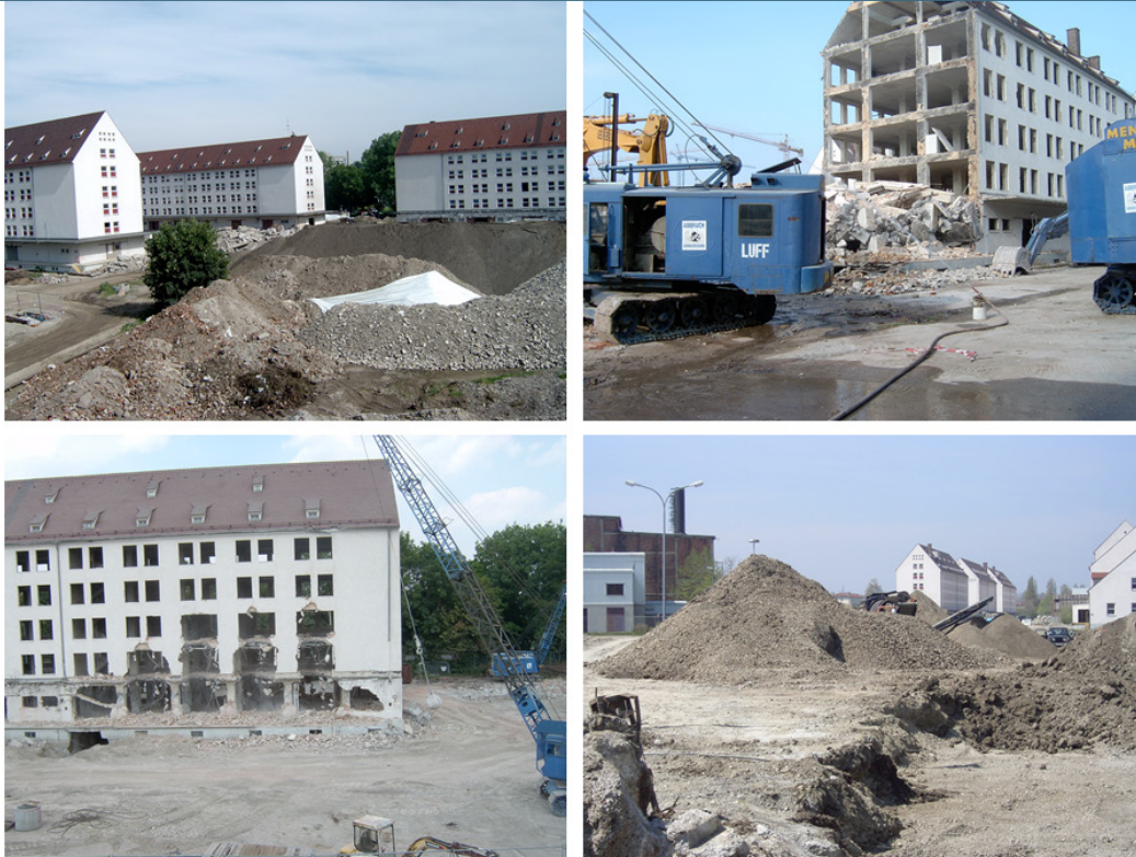
Teilabbruch und Umnutzung ehemaliger Kasernen zu einer Seniorenresidenz in Augsburg | Fotos: Bernhard Spielberger, Albaretto Hotel-Residenz
