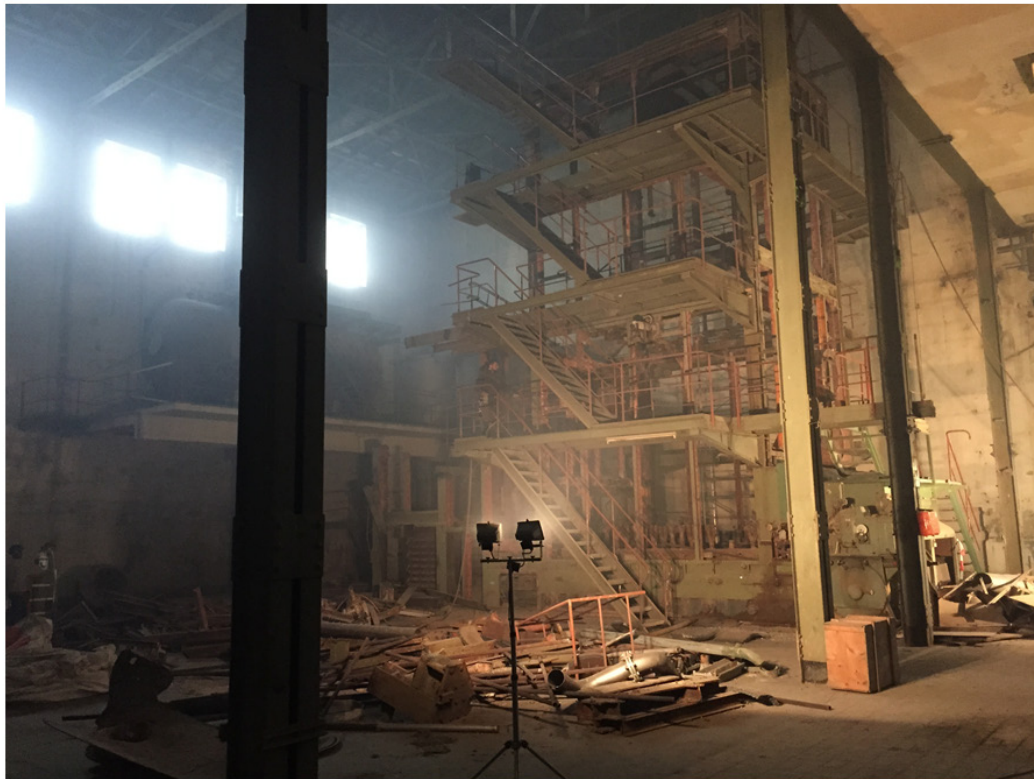
Umbau des ehem. AKS-Kesselhauses zu einem Hotel | Foto: Schäfflerbachstraße Grundbesitz GmbH | 3+Architekten Glogger, Müller, Blasi
