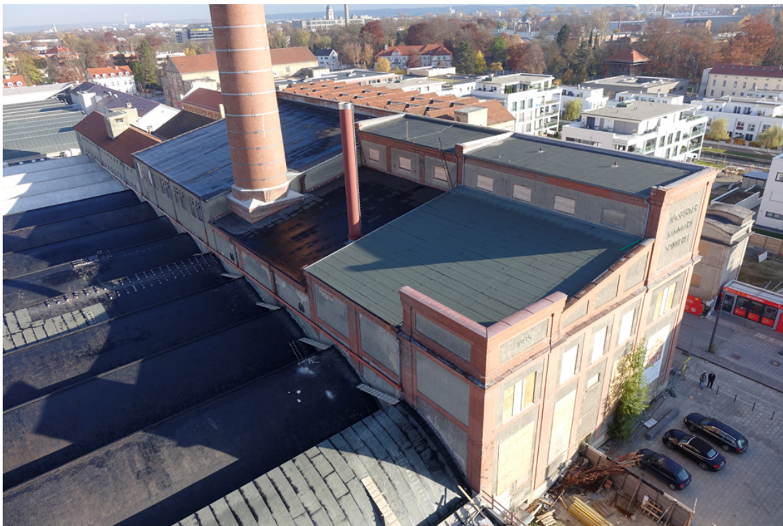
Umbau des ehem. AKS-Kesselhauses zu einem Hotel | Foto: Schäfflerbachstraße Grundbesitz GmbH | 3+Architekten Glogger, Müller, Blasi
