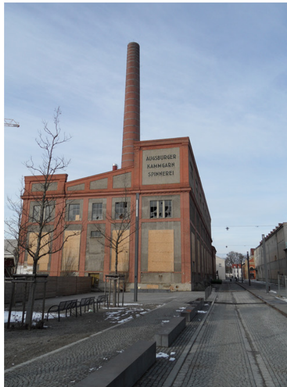
Ehemaliges Kesselhaus der Augsburger Kammgarnspinnerei | Foto: Günter Billenstein
