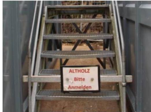
Beschädigte Aufstiegshilfen: verbogenes Geländer bzw. verbogenen Stufe
