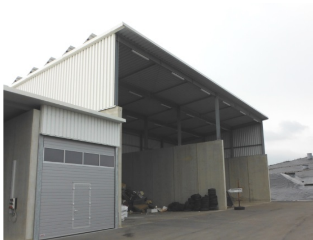
Abb. 14: Lagerbox für Abfälle
