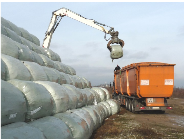
Abb. 4: Rückbau des Ballenlagers
