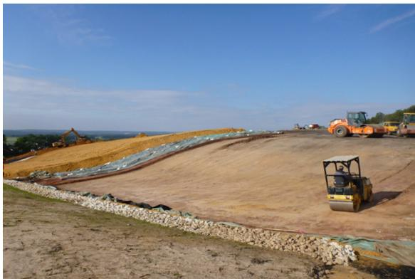
Abb. 10: Herstellen der Oberflächenabdichtung
