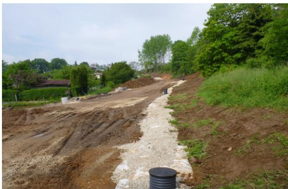
Abb. 14: Sickerwasserleitungen
