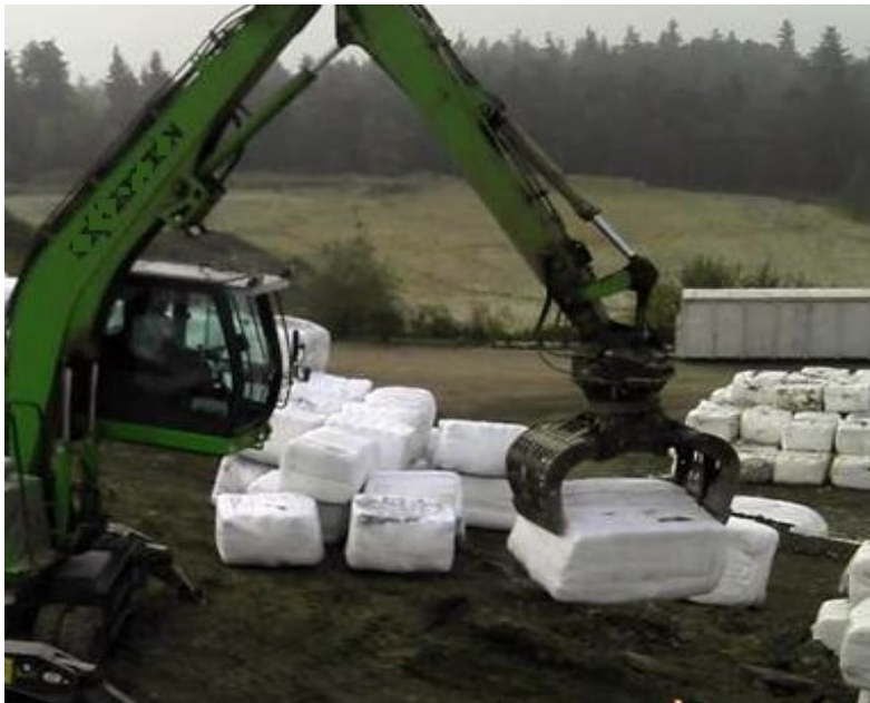
Abb. 1: Einbau verpresster KMF-Abfälle auf einer Deponie
