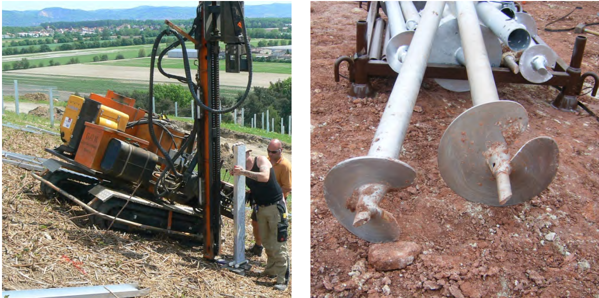
Abb. 4: Fundamenttypen: Ramppfähle (links), Drehfundamente (rechts)
