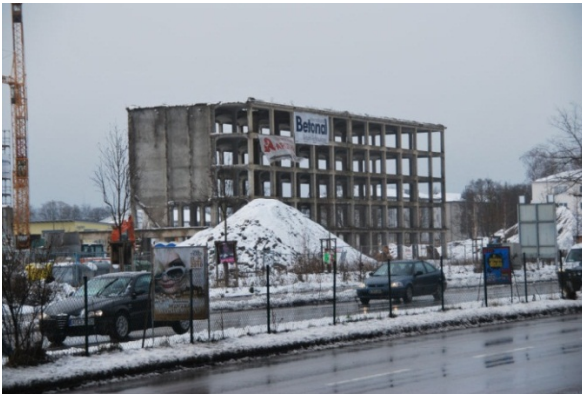
Abb. 3: Stahlbetonständer einer ehemaligen Kaserne zur weiteren Verwendung (hier wurden etwa 30 % Abbruchabfall vermieden) für...
