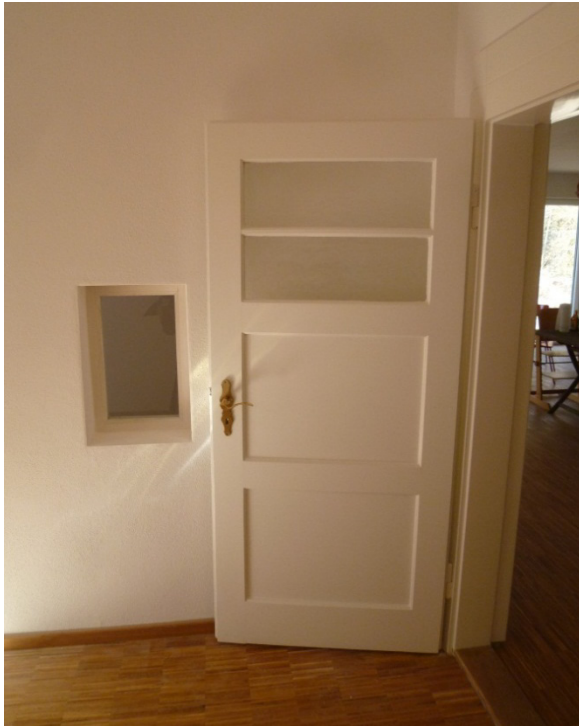
Abb. 17: eingebaute Holztür aus dem Abbruch- haus und ein ehema- liges Außenfenster (s. Abb. 8)
