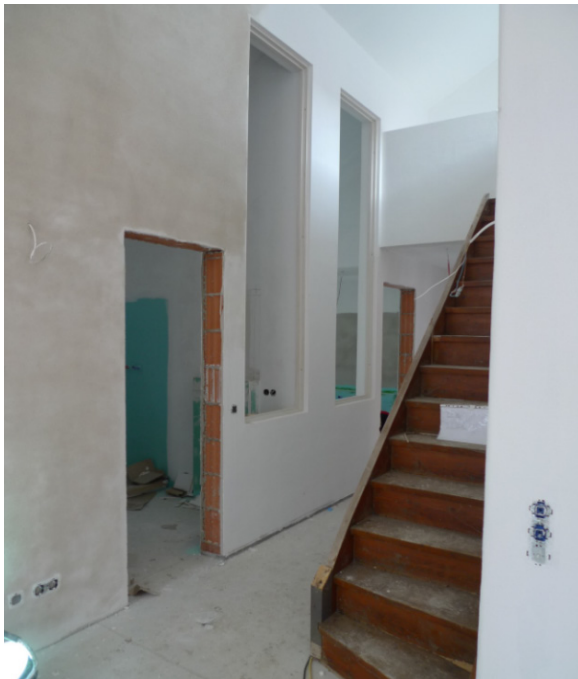
Abb. 19: Als Innenfenster weiterverwendete ehemalige Außenfenster aus dem Rückbau eines Bürogebäudes in München
