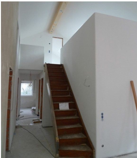
Abb. 18: eingebaute Treppe aus dem Abbruch- haus (s. Abb. 4)
