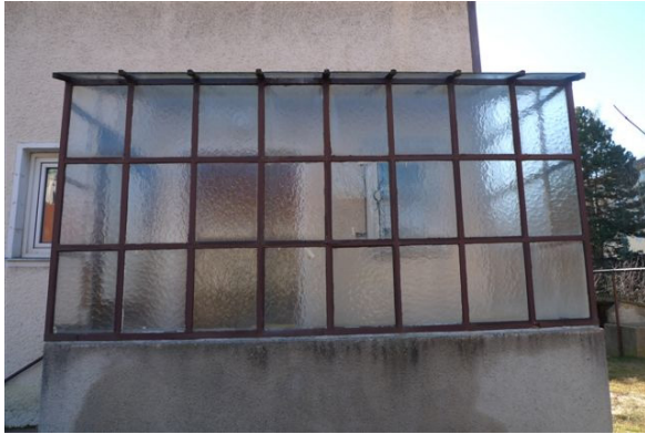
Abb. 10: Windfang vor der Bergung
