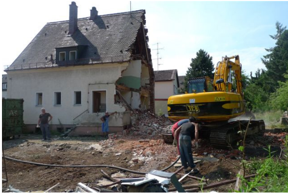
Abb. 8: Konventioneller Abbruch eines Altbaus auf dem Nachbargrundstück, aus dem einige der erhaltenen Bauteile stammen.
