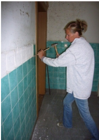
Abb. 12: Ausbau von Fliesen
