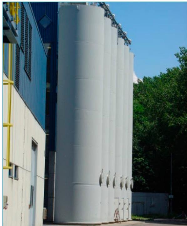
Abb. 2: Endkontrollbehälter der Abwasserreinigungsanlage der SAV in Ebenhausen
