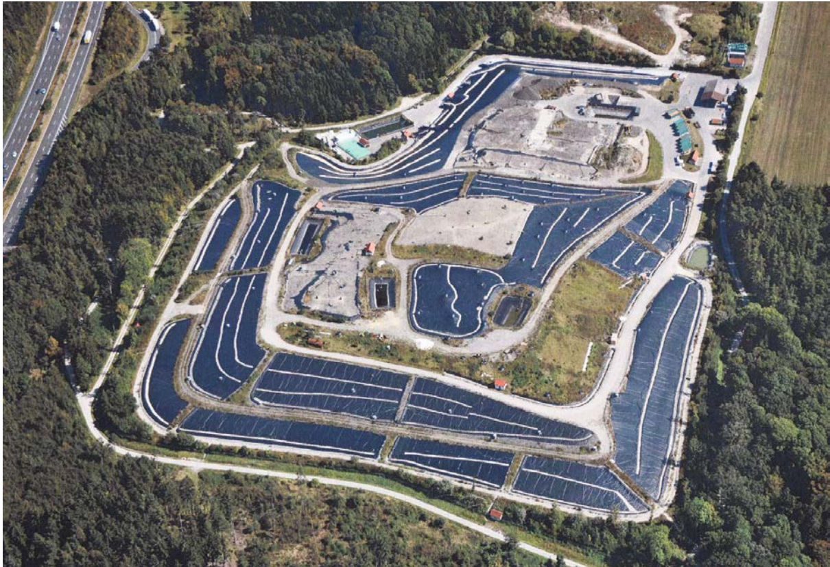
Abb. 1: Deponie „Im Dienstfeld“ mit Gasbrunnen und temporärer Oberflächenabdichtung
