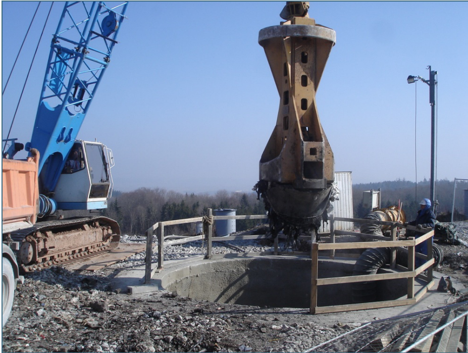
Abb. 2: Spezialbagger beim Ausheben der Start- grube
