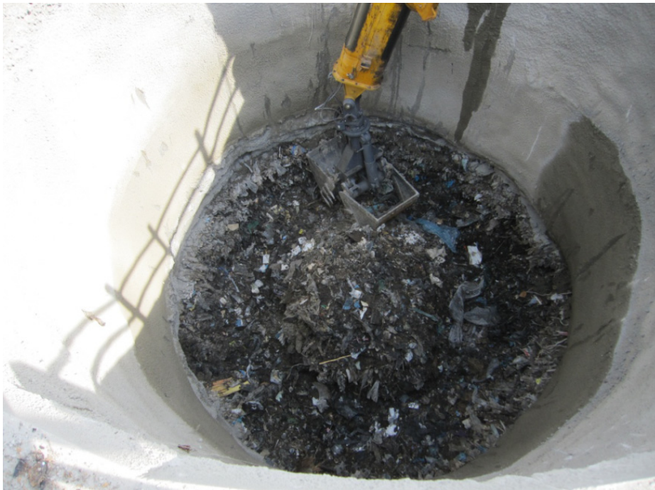
Abb. 4: Startgrube mit bewehrten Grubenwänden
