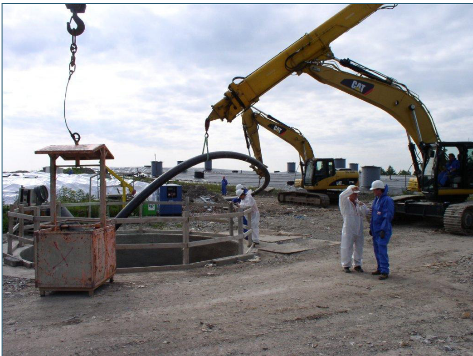
Abb. 3: Einziehen des neuen Sickerwasserrohres in die Startgrube
