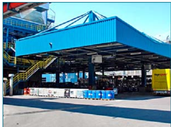
Abb. 2: GSB Baar-Ebenhausen – Lagerfläche für gefährliche Abfälle
