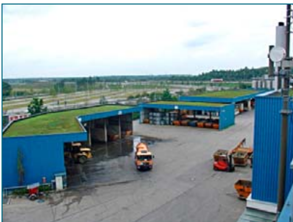
Abb. 1: GSB München - Sammelstelle für gefährliche Abfälle
