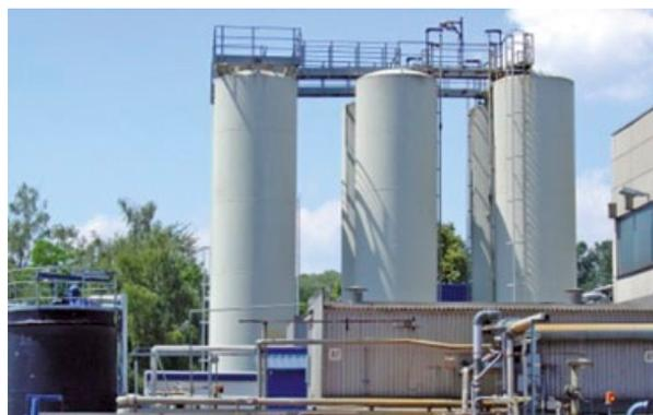
Bild 6: Regenausgleichsbehälter
