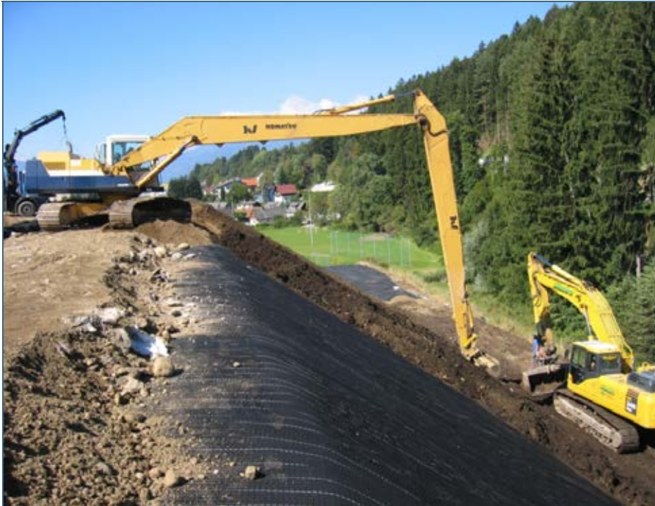
Abb. 3: Aufbau einer Rekuschicht auf einer übersteilen Böschung, Österreich
