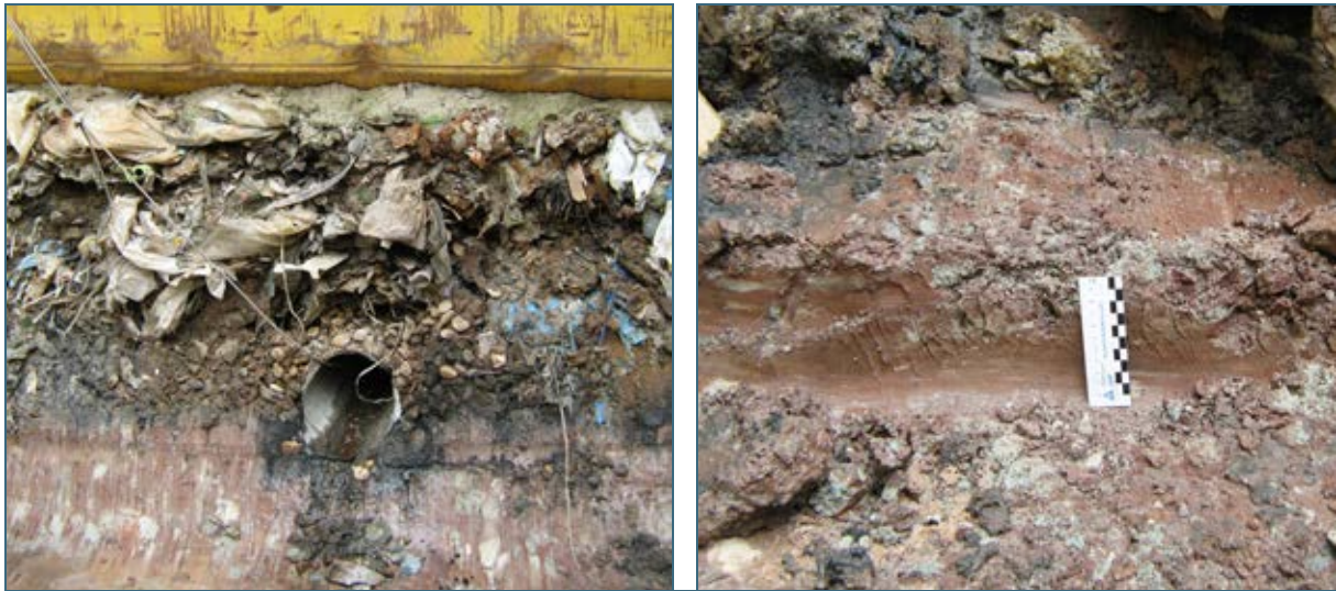
Abb. 1: Freigelegte Basisabdichtung in der Baugrube SS1, Deponie „Im Dienstfeld“
