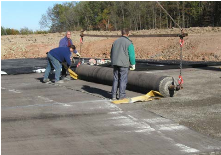
Aufbringung von Bentonitmatten
