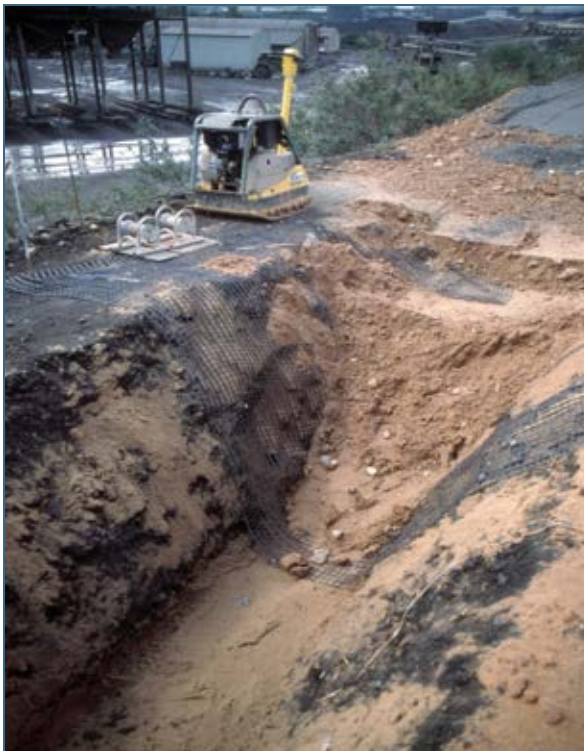
Abb. 5: Platzsparende Ausführung einer Verankerung in einem Ankergraben
