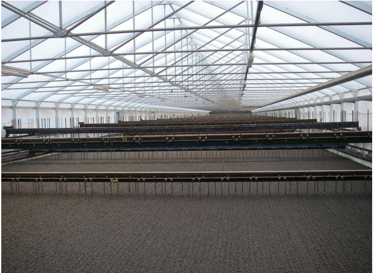
Abb. 8: Solarunterstützte Klärschlamm-trocknung
