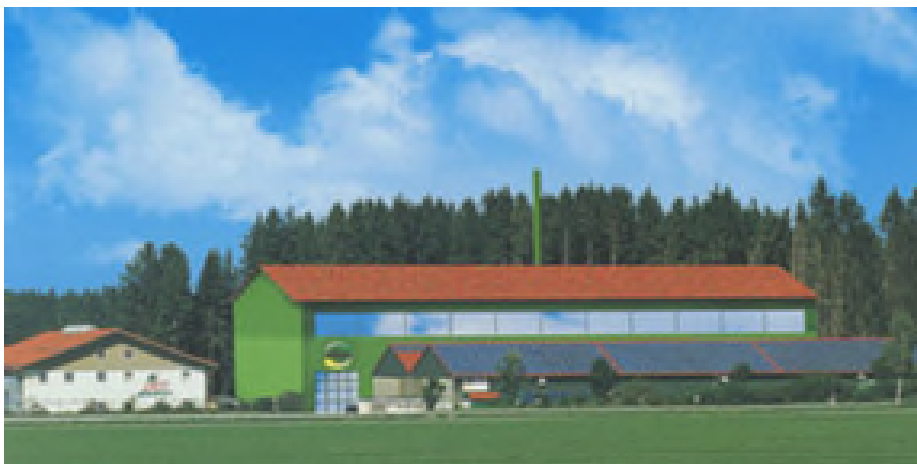
Abb. 9: Klärschlamm-monoverbrennungsanlage der Fa. Emter
