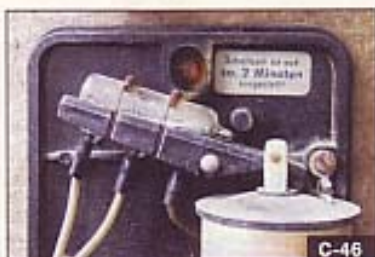
Quecksilberschalter – Treppenlicht- automat
