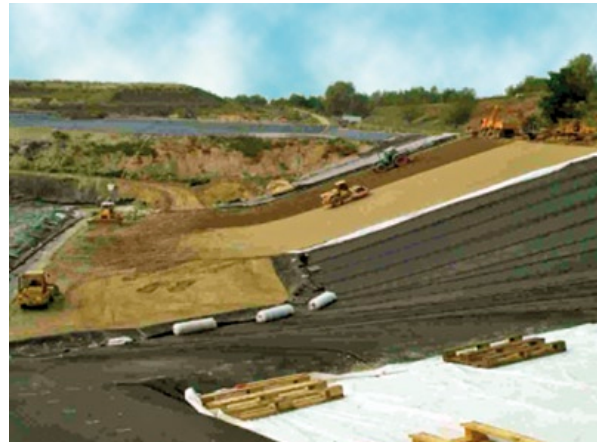
Abb. 4: Basisabdichtung Sonderabfalldeponie Gallenbach
