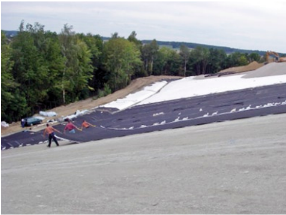
Abb. 3 : Oberflächenabdichtung Sonderabfalldeponie Gallenbach
