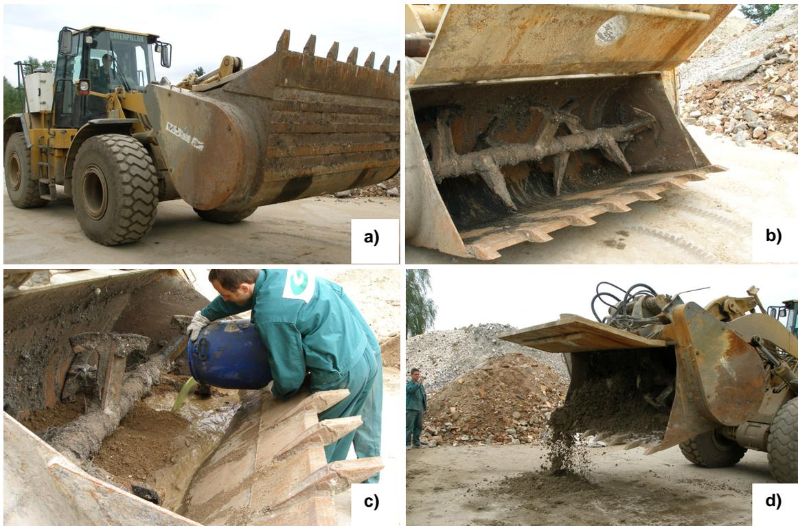
Abb. 7: Fallstudie Pigmentproduktion II, Bodenbehandlung nach dem Geodur-Verfahren (Technikumsmaßstab); Radlader (a) mit Mischschaufel (b), Beaufschlagung des Bodens mit in Wasser gelöstem Additiv (c), Produktaustrag (d).
