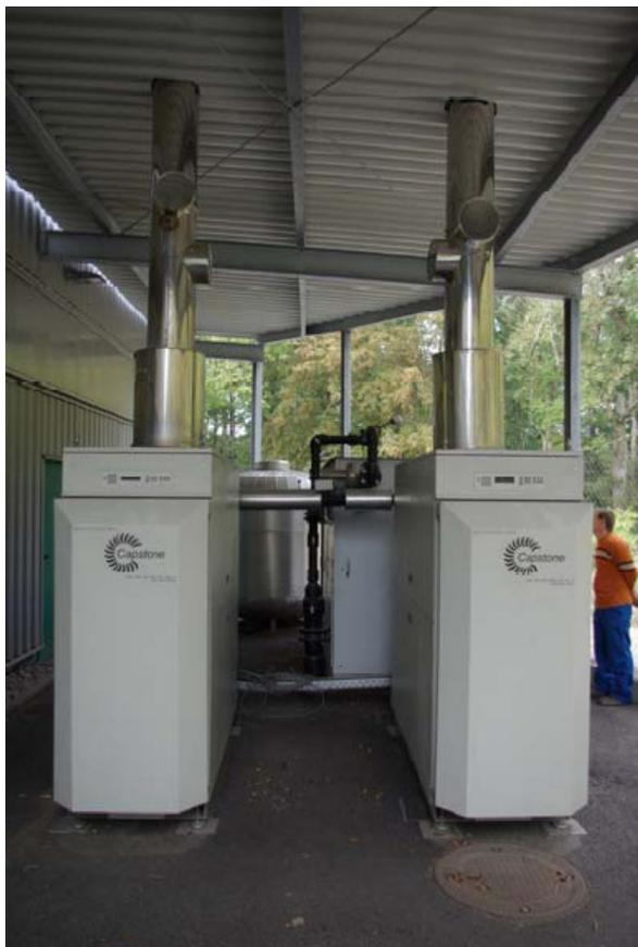
Abb.12: Mikrogasturbinenanlage Deponie Eichelbuck
