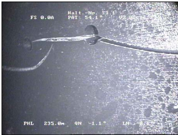
Abb.10: Typischer Längsris beginnend an einem Drainageloch
