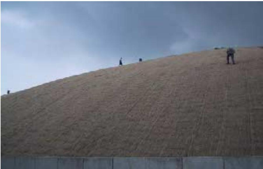
Abb. 10: Jute Matten zum Erosionsschutz zur nachfolgenden Spritzbegrünung am 26.07.05
