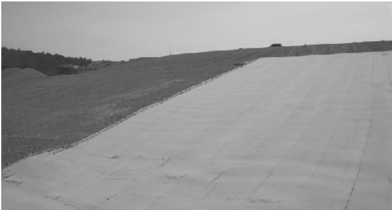
Bild 3: Eingebaute TRISOPLAST®-Dichtung auf der Deponie Schippach im Juli 2005
