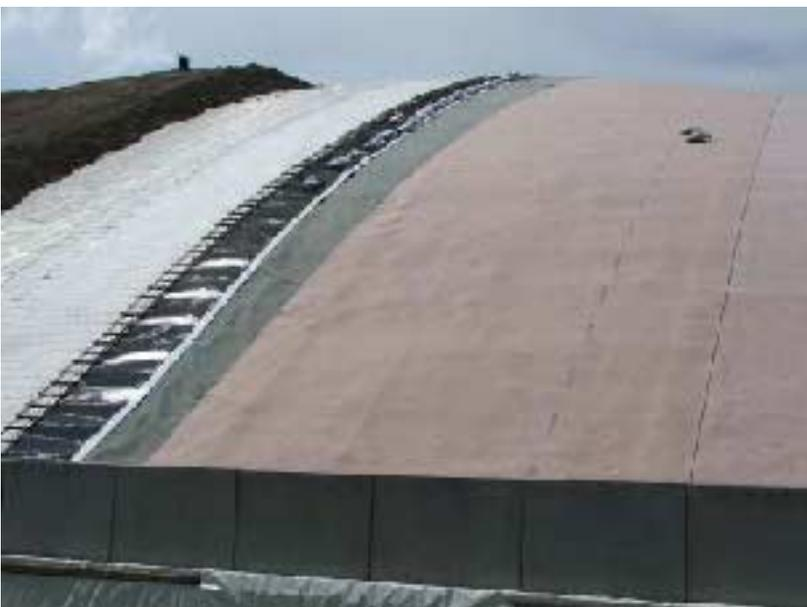
Abb. 8: Nach Freigabe weiterer Einbau der Systemdichtungen
