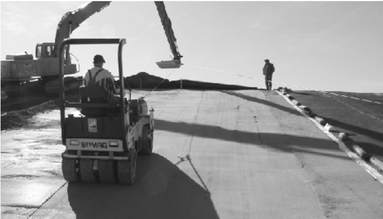
Bild 4: Einbau von TRISOPLAST® und KDB auf der Deponie Oberlangheim
