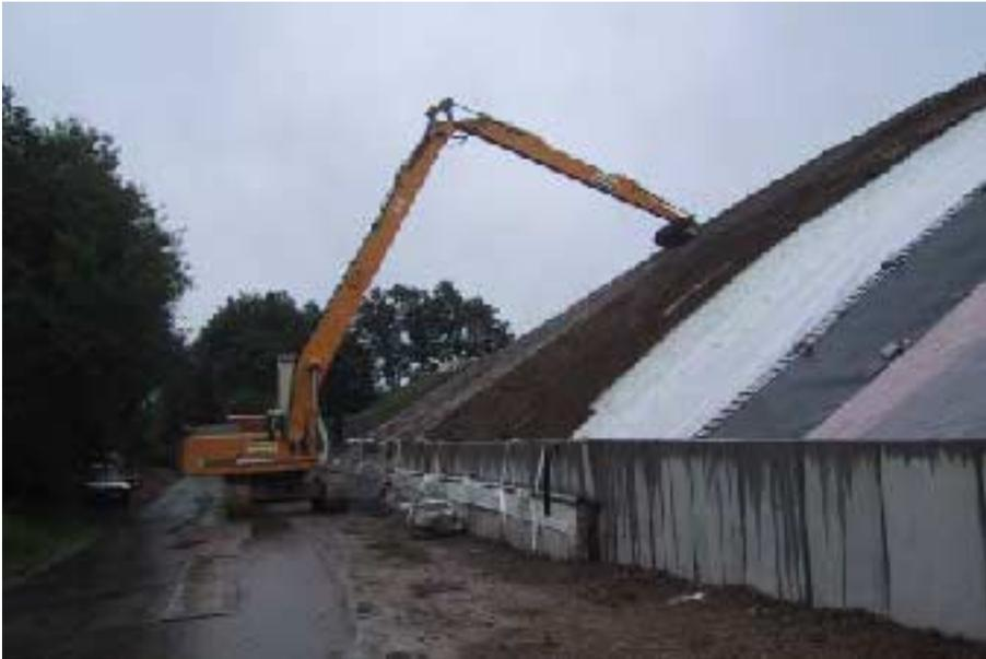
Abb. 9: Einbau des ReKu-Materials
