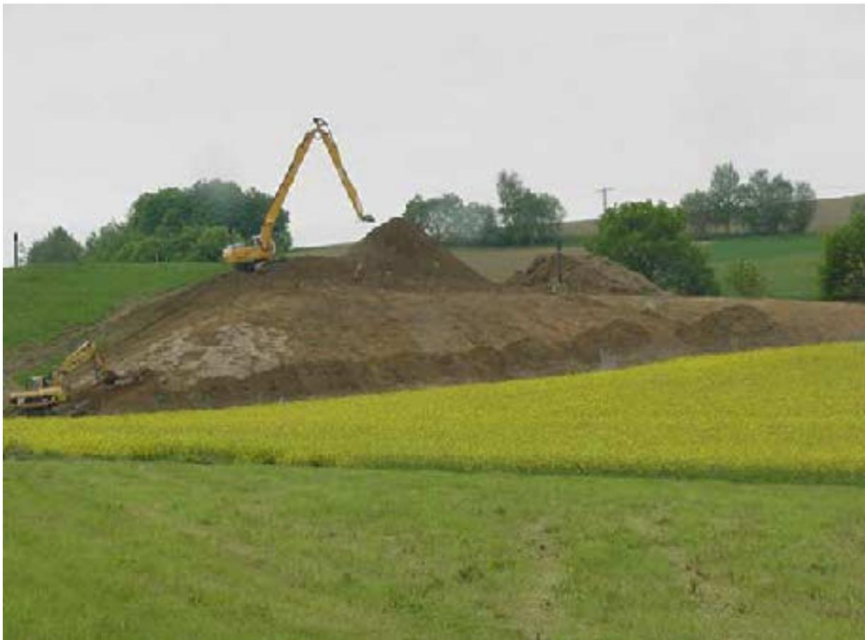
Abb. 1: Abtrag der bestehenden ReKu-Schicht
