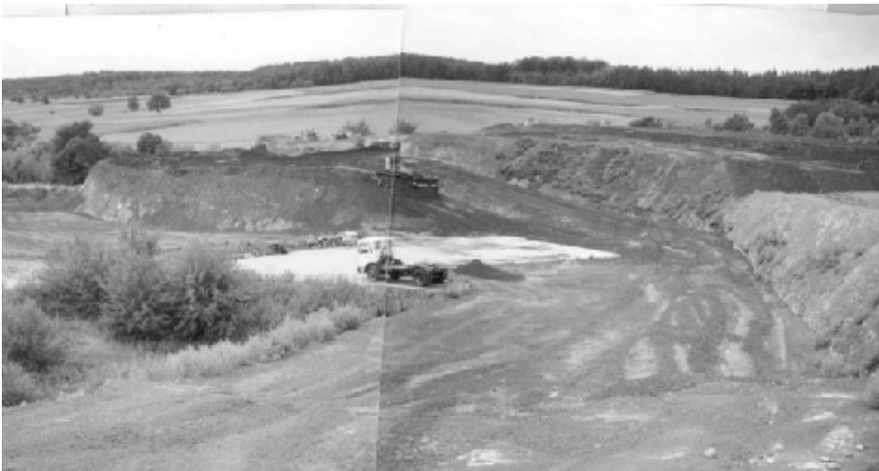
Bild 2: Einbau von verfestigten Klärschlämmen auf der Deponie Schippach im Jahr 1993
