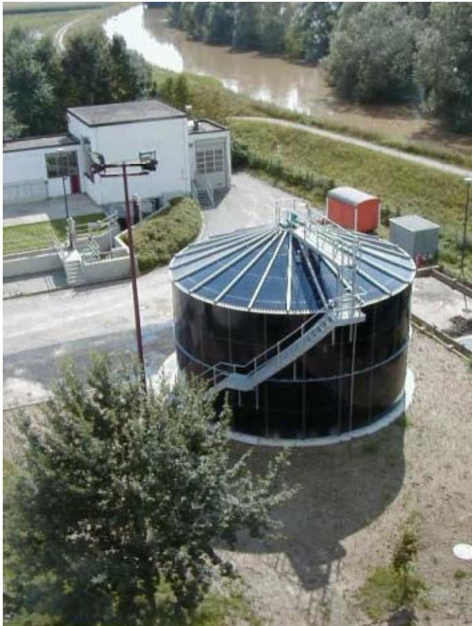
Abb. 5.1: Schlammstapelbehälter für externe Schlämme auf der Kläranlage Straubing
