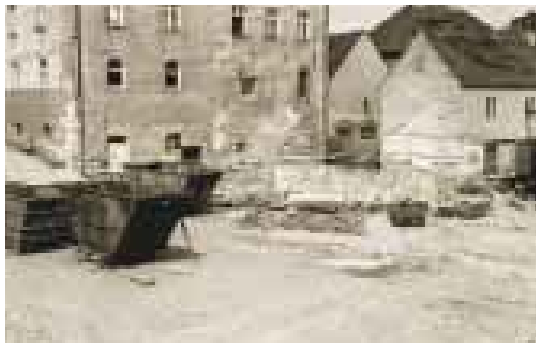
Baustellensituation 1981, 6 Tage nach Schadensentdeckung
