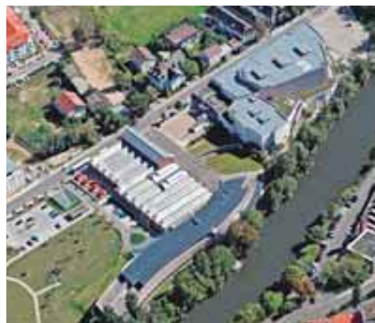
Neubebauung des Altstandortes „Bamberger Kaliko“ mit hochwertiger Bebauung
