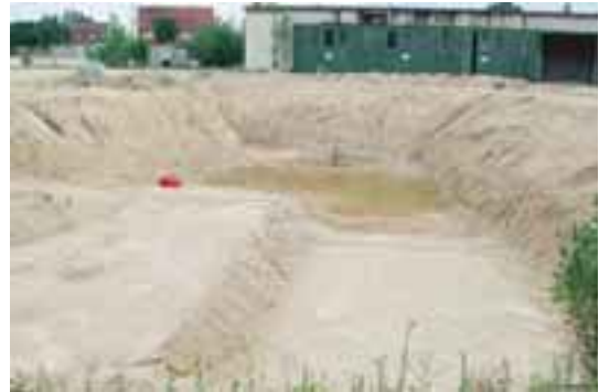
Bodenaushub einer ehemaligen Tankstelle
