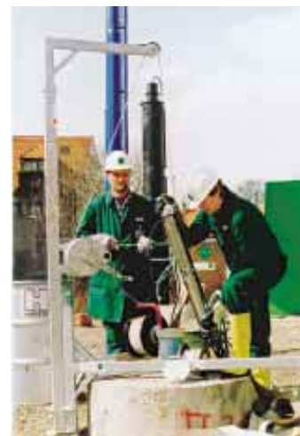
Einbringen einer Tauchpumpe in einen Tiefbrunnen
