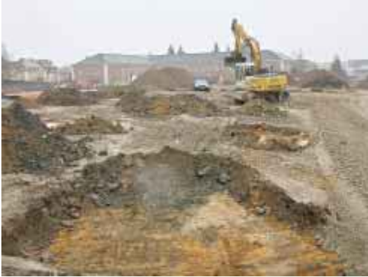
Bodensanierung auf einem Altstandort
