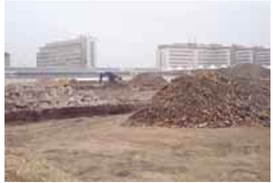
Flächenrecycling auf einem ehemaligen Gaswerksstandort
