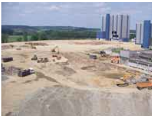
Abschluss der Sanierungsmaßnahmen mit Einbau der güteüberwachten Recyclingbaustoffe
