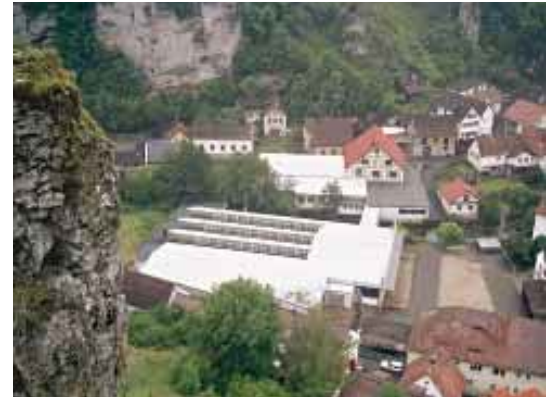
Altstandort in beengter Lage neben dem Ortskern
