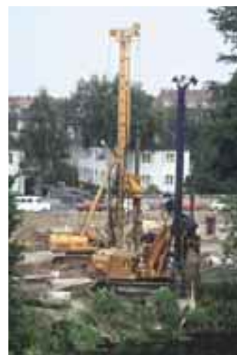
Ehemaliges Betriebsgelände mit der Regnitz im Vordergrund Sanierungsarbeiten
