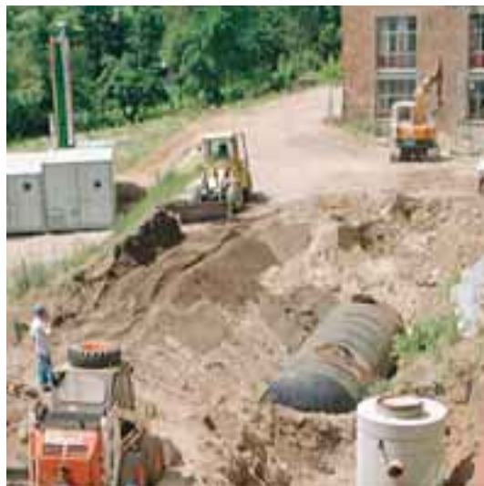
Aushub einer Tankanlage
