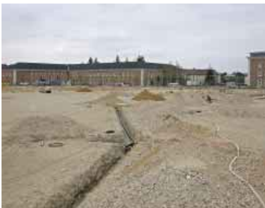
Installation einer Air-Sparging-Anlage
