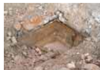
Abbruch eines Raumes Leere Neutralisationsgrube
