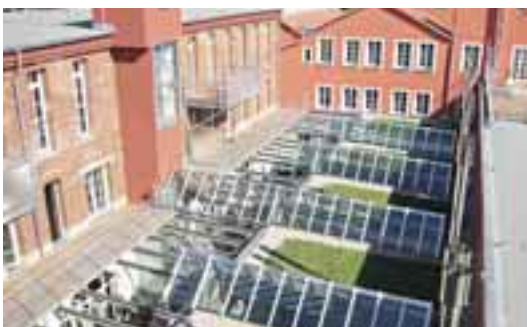
Hochwertige Nachnutzung eines Altstandorts mit Loftwohnungen
