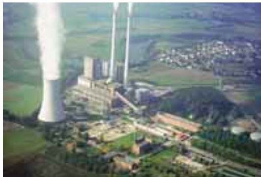
Luftbild des ehemaligen Braunkohlekraftwerks Dachelhofen
