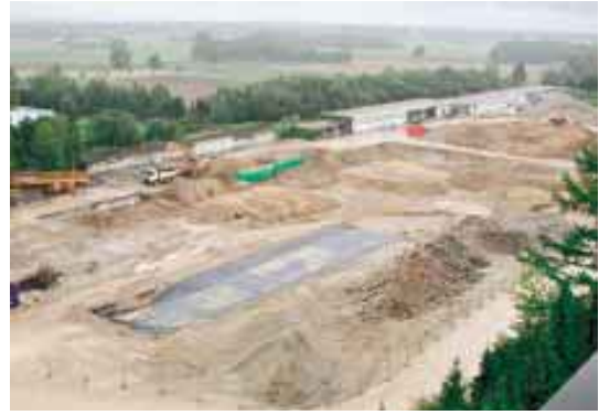
Sanierung durch Bodenaushub
