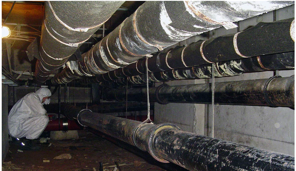
Bestandsaufnahme Rohrisolierungen
