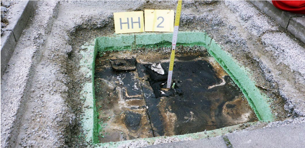
Bestimmung des Schichtaufbaus einer Dachabdichtung
