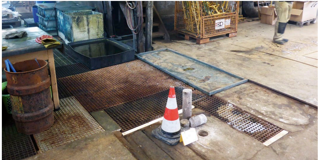
Kernbohrung in einem galvanischen Betrieb
