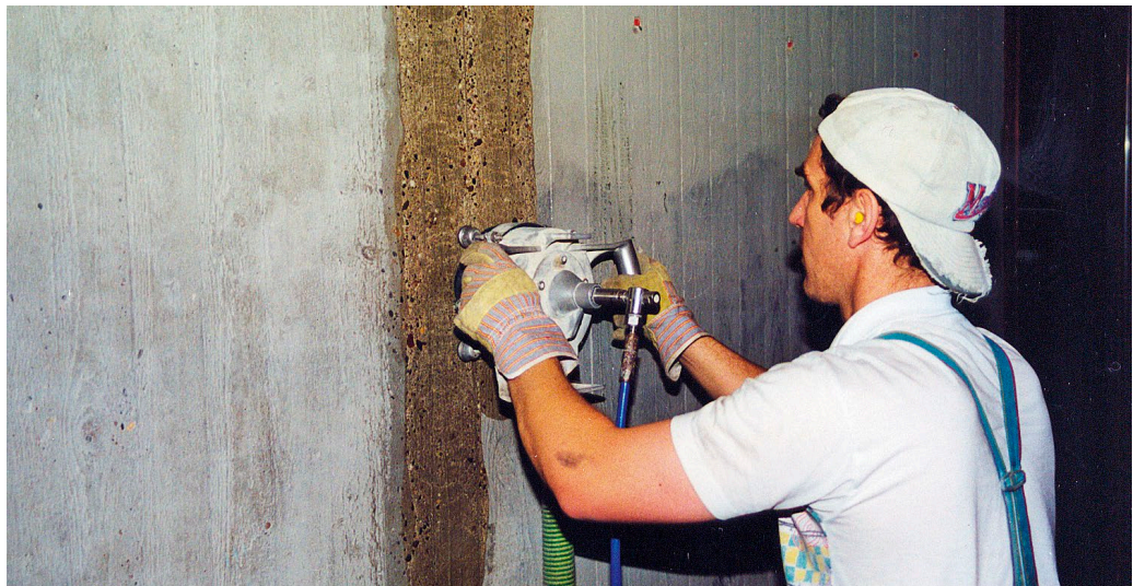
Abtrag mit einem Hochdruckwasserstrahl (HDW)
