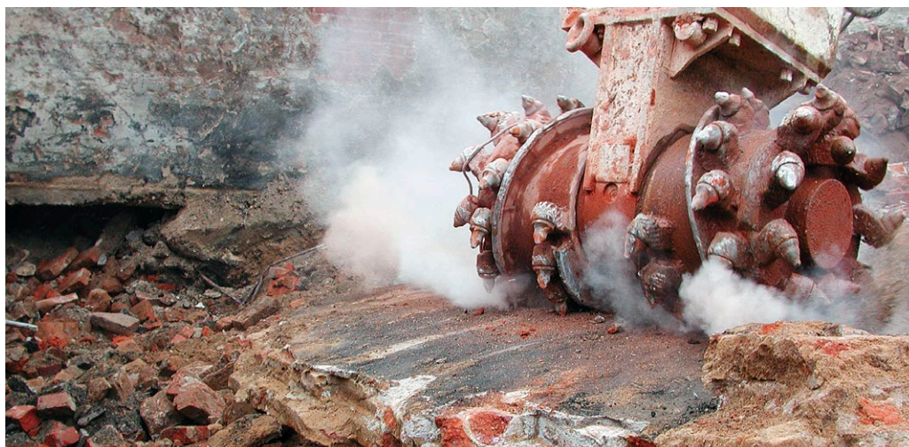
Staubfreisetzung an einer Fräse
