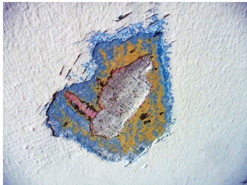
Links: Mehrere Farb- und Spachtelschichten übereinander
