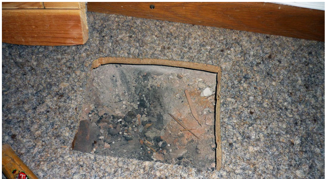
Schlacke als Fehlbodenfüllung
