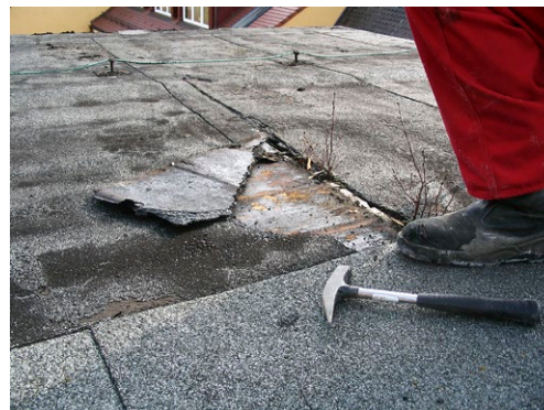
Oben links: Asbestzement-Schindeln als Fassadenbekleidung
