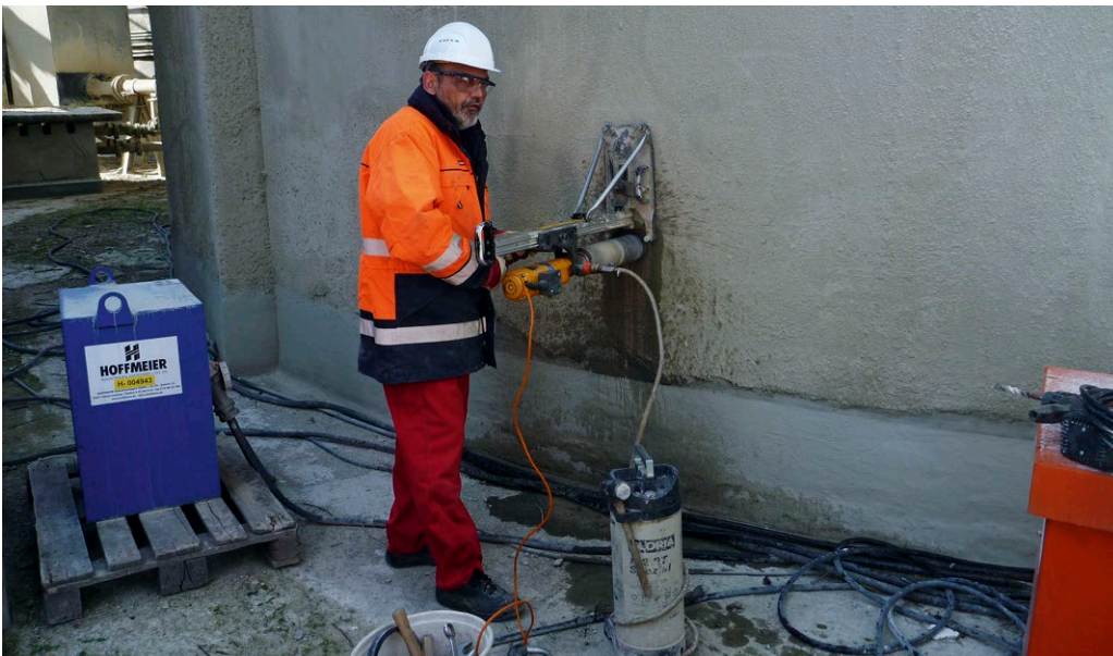
Kernbohrung
