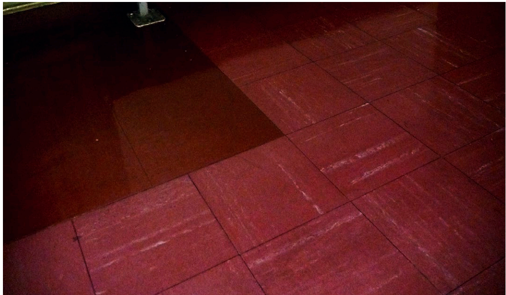
Bodenbelag aus Floor-Flex-Platten
