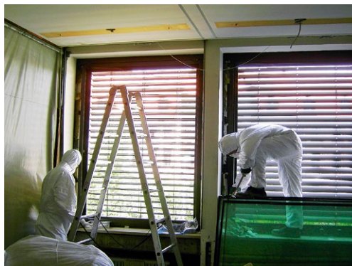
Links: Ausschneiden von elastischen Fugenmassen an Fenstern
