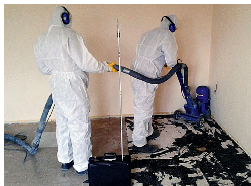
Links: Einsatz eines Asbestsaugers bei einer Flexplattensanie- rung
