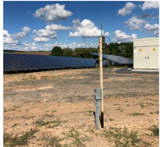
Neue PV-Anlage mit postiertem Batcorder
