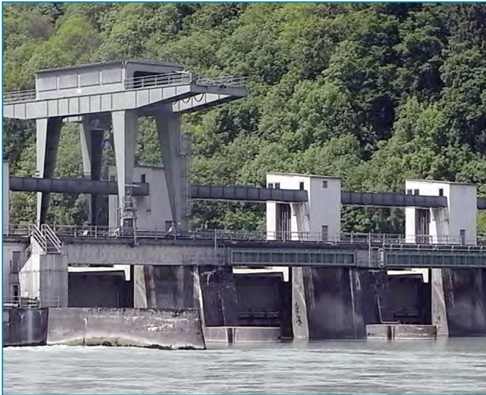
Typisches Wasserkraftwerk am Inn
