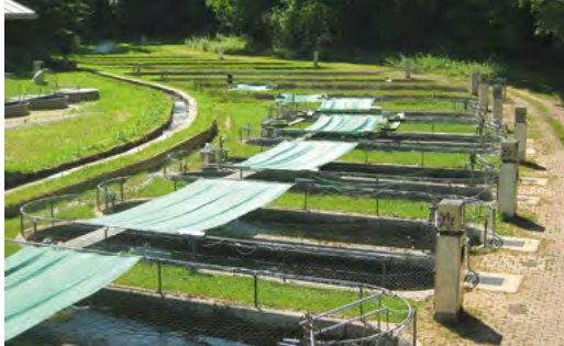
Becken einer Forellenzuchtanlage (Foto: LfL Starnberg)
