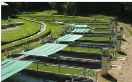
Becken einer Forellenzuchtanlage (Foto: LfL Starnberg)
