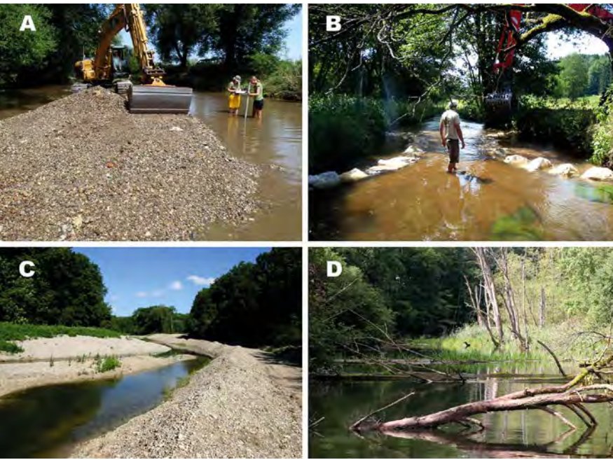
Abbildung 1 Typische Beispiele für Maßnahmen zur Restaurierung von Fließgewässern: (A) Substratrestaurierung zur Förderung kiesliebender Fischarten, (B) Strukturverbesserung zur Erhöhung der Habitatdiversität, (C) Wiederherstellung der fischökologischen Durchgängigkeit, beispielsweise durch Umgehungsgewässer, (D) Einbringen von Totholz als Unterstand und Juvenilhabitat für Fische (Fotos: TUM-Aquatische Systembiologie).
