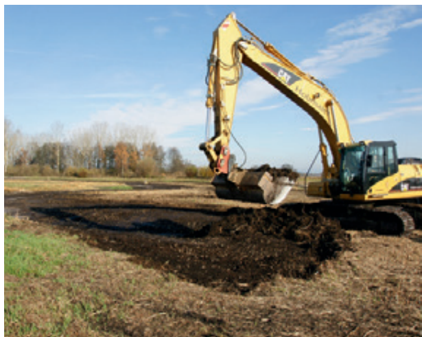
Durch den Aushub von Mulden mit sehr flach auslaufenden Randbereichen entstehen so genannte Seigen, die sich nach starken Regenfällen mit Wasser füllen. Diese künstlich geschaffenen Nassstellen dienen als Kompensation. Gleichzeitig zählen sie zu den CEF-Maßnahmen für den Kiebitz.
