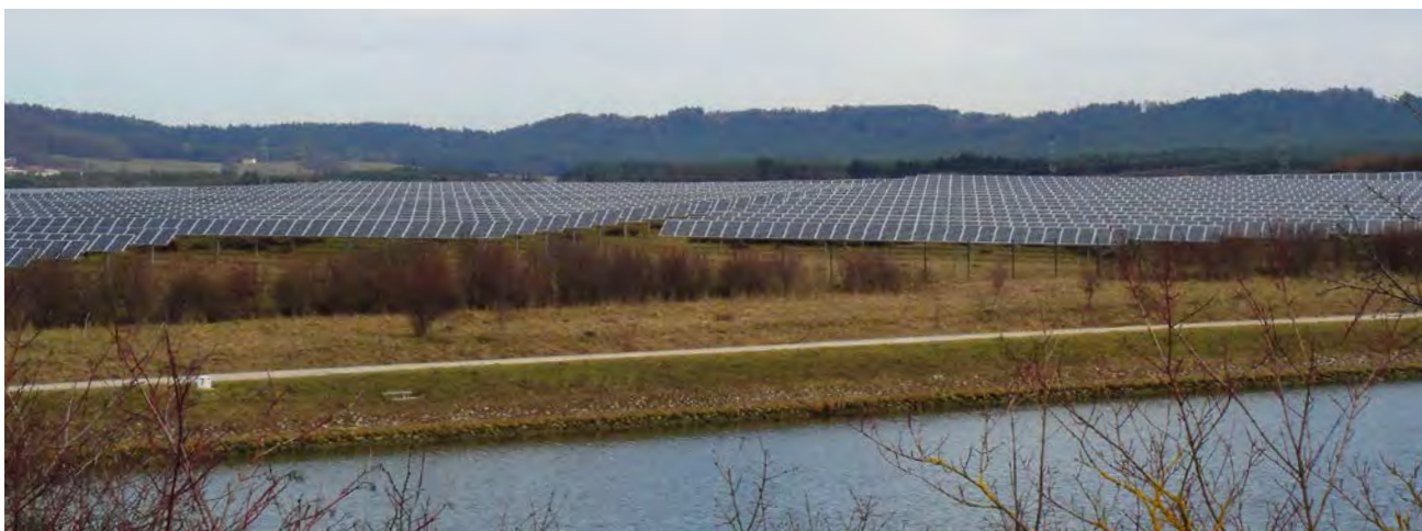
Abb. 2: Solarpark Mühlhausen, im Vordergrund der Main-Donau-Kanal (alle nicht gekennzeichneten Fotos: Bernd Raab).
