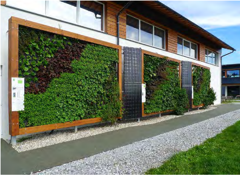
Im „GrünAktivHaus“-Projekt, untersuchen die TU Wien, BOKU und 16 Unternehmen an drei verschiedenen Fassadensystemen, wie sich Photovoltaik und Fassadenbegrünung kombinieren lassen (Foto: Azra Korjenic).
