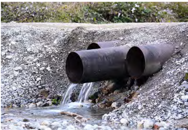
Mit einer einfachen Kartieranleitung kann festgestellt werden, ob Durchlässe kleiner Fließgewässer ein Durchgängigkeitshindernis darstellen (Foto: ecoline/Andreas Zehm).
